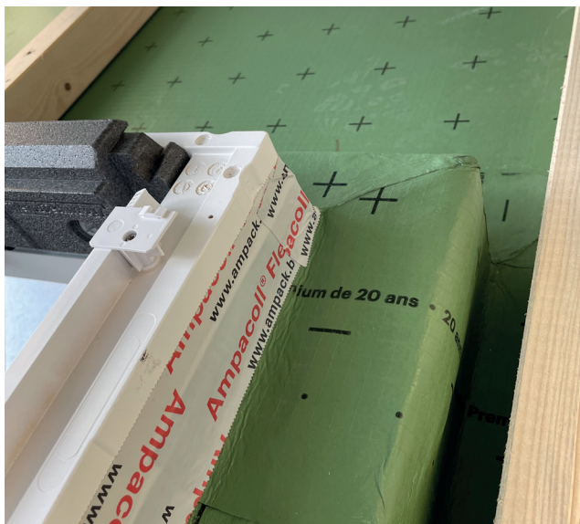
Abkleben der Unterdachbahn am Dachfenster.
