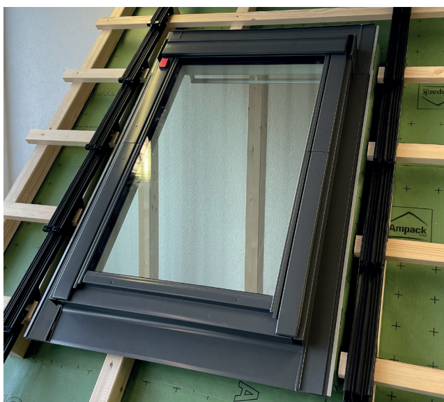
Fertig montierter Eindeckrahmen ODL.
