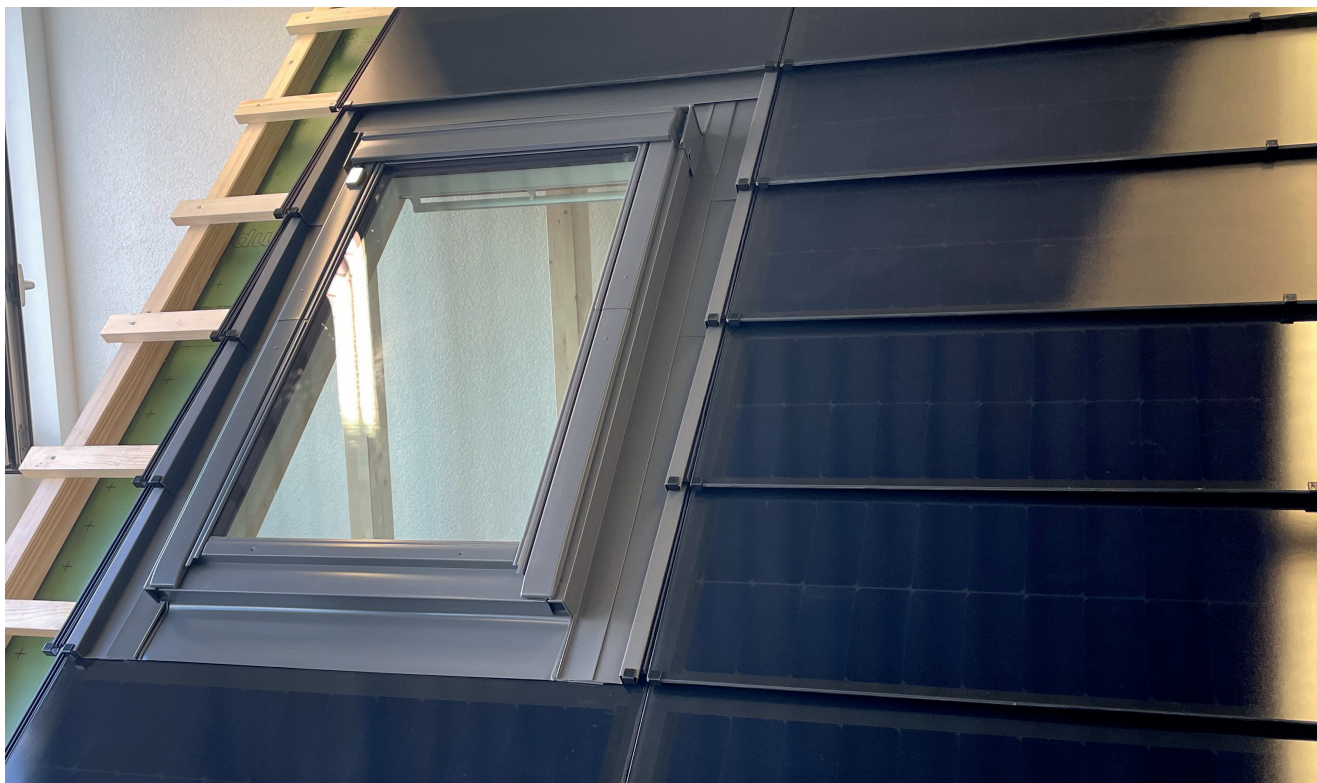
Dachfenster der Grösse MK06 78x118cm mit original VELUX ODL Eindeckrahmen, MATCH slate Module Mxx-HC24 (Optik totallyblack Crystal / Fjord)
