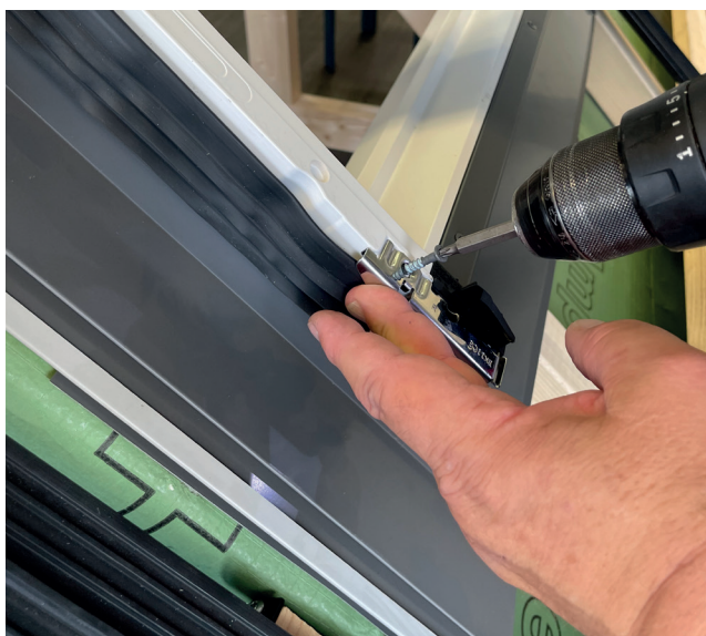
Drainagen 2a und 3a am Eindeckrahmen anbringen.
