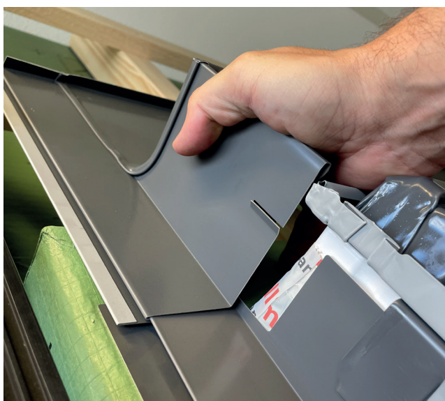
Kopfstück Eindeckrahmen in den seitlichen Falz einschieben.
