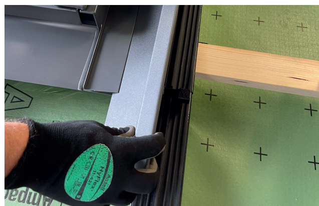
Anbringen der bauseitigen Abschlussbleche. Beginnend mit "Übergangsblech unten L & R für MK06-SK06-MK10-SK10". Zeichnungen der Bleche am Ende des Dokuments.
