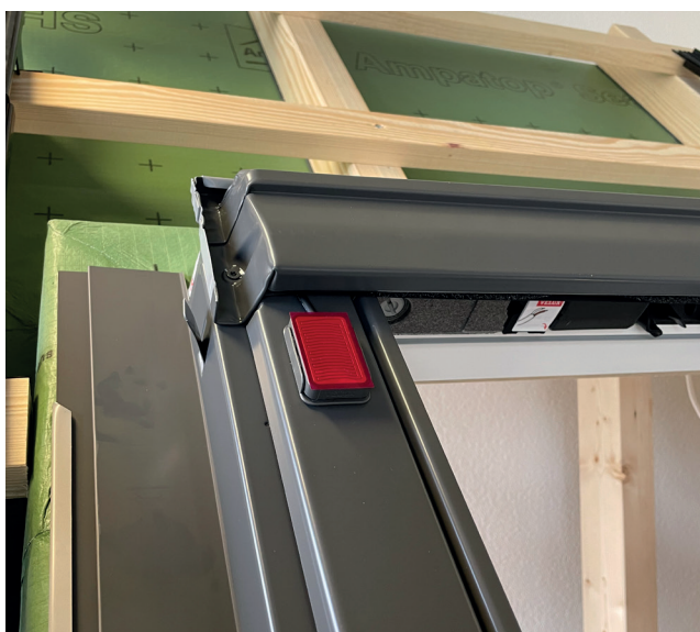
Montage du caisson de store.
