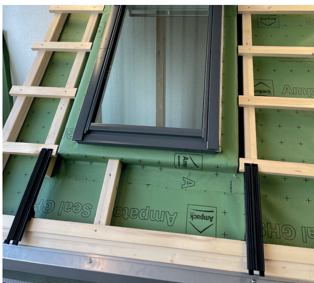
Fixer les crochets Megasol MATCH Slate selon les informations de planification ou la répartition individuelle.
