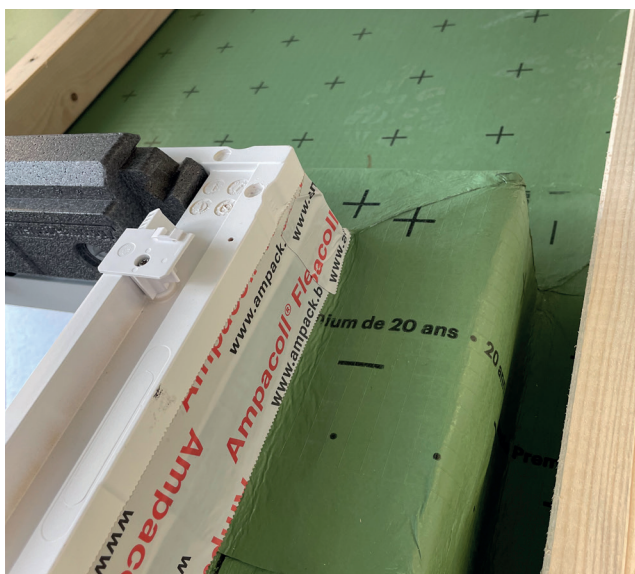
Collage de l'écran de sous-toiture sur la fenêtre de toit.
