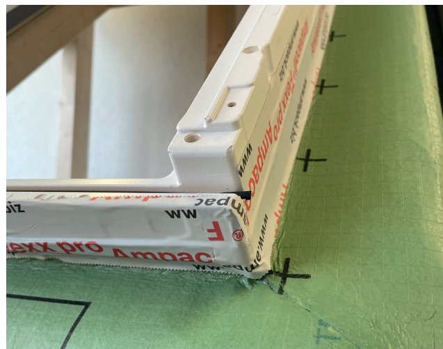
Appliquer une bande d'étanchéité pour clous sur le support (directives du fabricant de lés de sous-toiture) et le monter conformément au plan de lattage.
