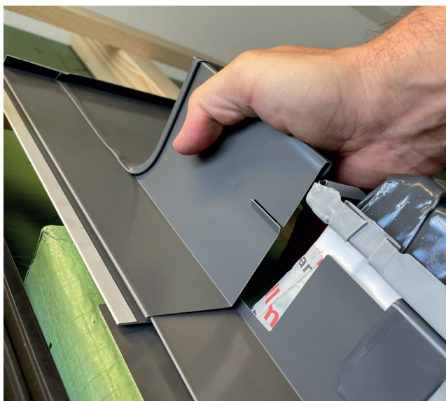
Insérez la tête du raccord dans la feuillure latérale.
