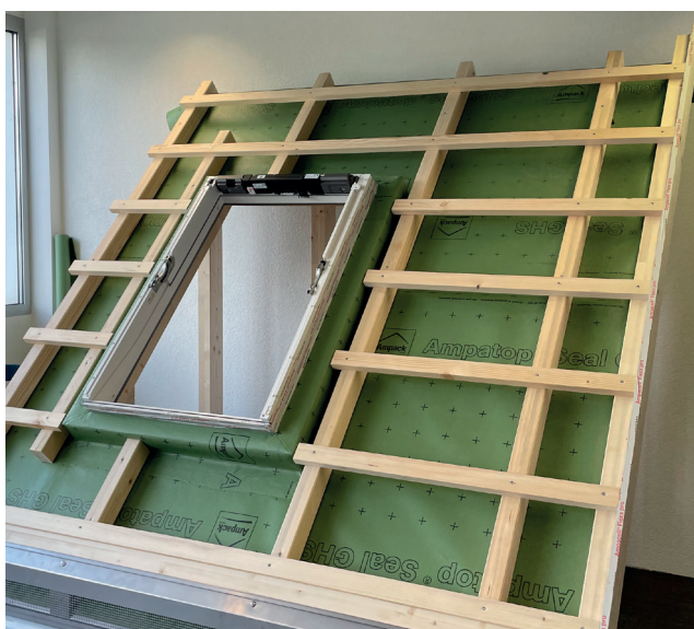
Appliquer une bande d'étanchéité pour clous sur le support (directives du fabricant de lés de sous-toiture) et le monter conformément au plan de lattage.
