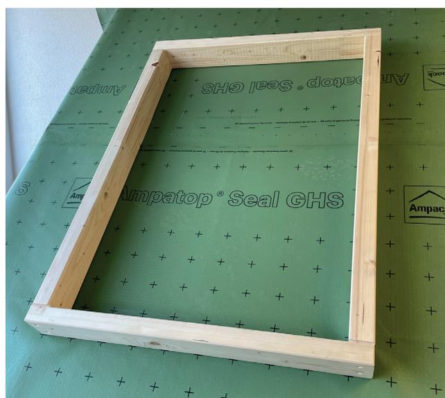
Posizionare il telaio di montaggio. Disposizione basata sui disegni tecnici Megasol MATCH Slate. Allineare, angolare e avvitare il controlistona.
