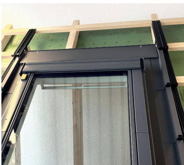
Fissare la piastra di ingresso in alto con viti per tetti ("Piastra di transizione superiore per MK06-SK06-MK10-SK10")
