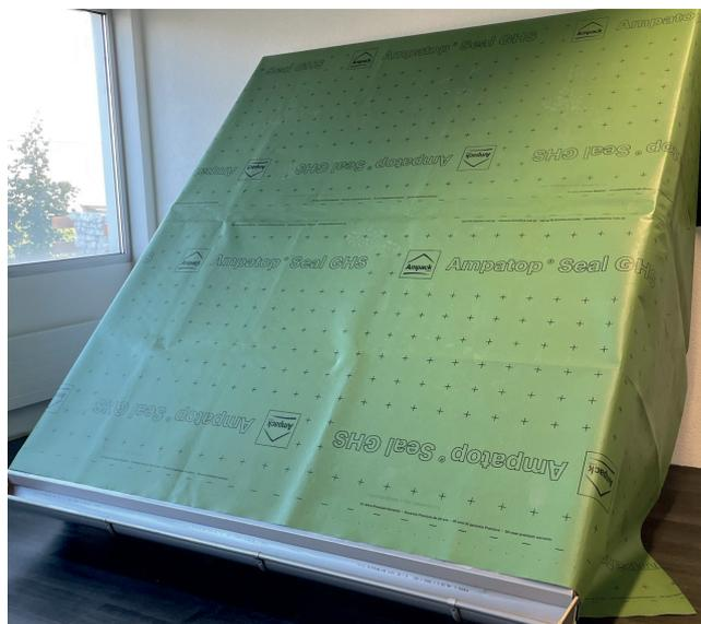
Applicare la membrana sottotetto su tutta la superficie (membrana sottotetto consigliata da Ampack: Ampatop® Seal GHS, omologata per 6 mesi in assenza di agenti atmosferici).
