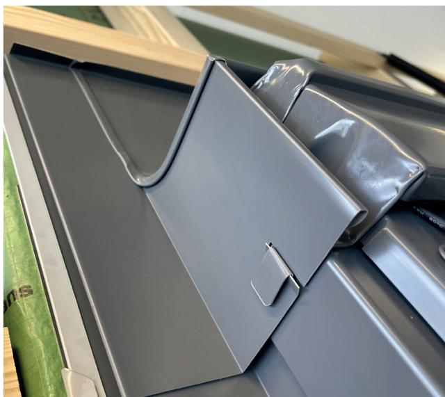
Ripiegare la linguetta sulla piastra di copertura del telaio.
