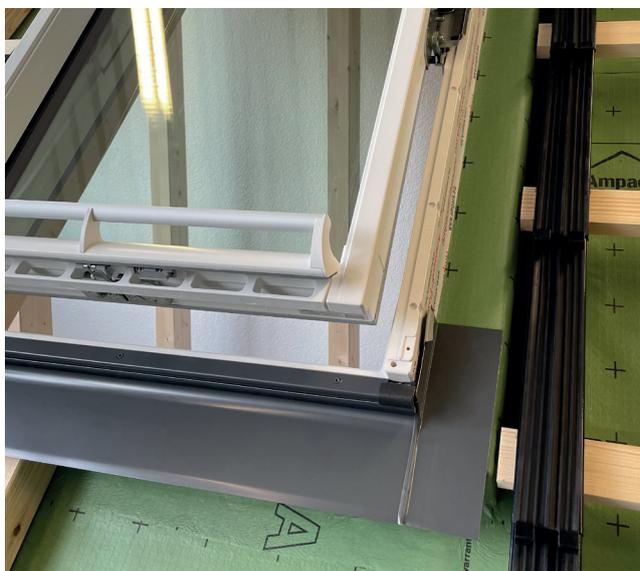
Montaggio della base scossalina VELUX (tipo ODL) e fissaggio della piastra Solbank PLUS (2a)
