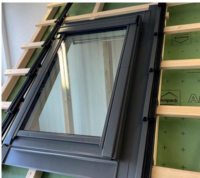
Aggiungere le piastre laterali coniche a sinistra e a destra ("Piastra di transizione R per MK06-SK06-MK10-SK10" e "Piastra di transizione L per MK06-SK06-MK10-SK10").
