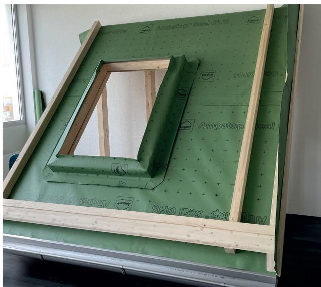
Controllare l'allineamento del controtelaio alla gronda. Dividere e aggiungere i controlistelli.
