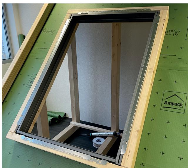
Assemblare il telaio isolante BDX e tagliare e posizionare le linguette ad angolo retto su tutti e 4 i lati.
