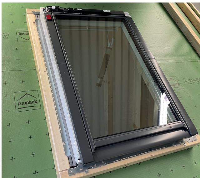
Allineare l'oblò nell'"angolo" e nell'"argano" e avvitarlo nel controtelaio.
