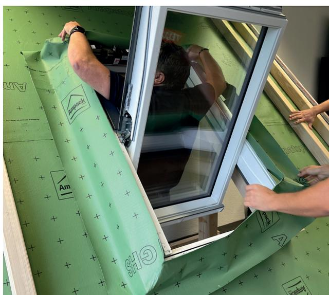
In alternativa, tirare la membrana sottotetto sul telaio di montaggio in modo convenzionale, secondo le istruzioni del produttore.
