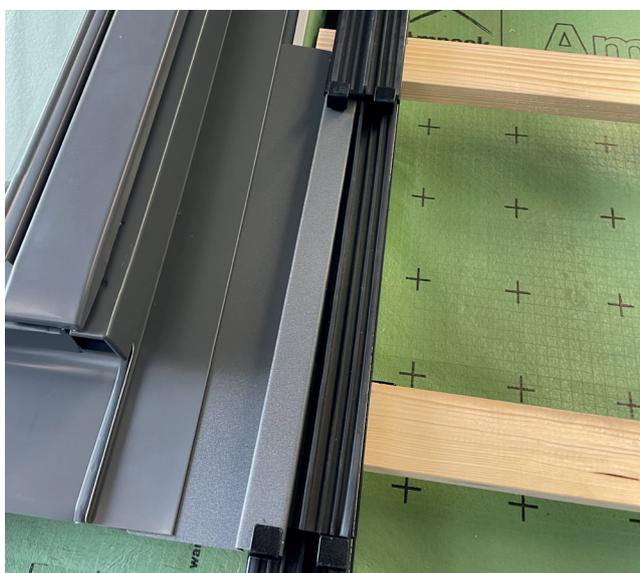
Montare le piastre terminali fornite dal cliente. A partire da "Piastra di transizione inferiore L e R per MK06-SK06-MK10-SK10". I disegni delle lamiere sono riportati alla fine del documento.
